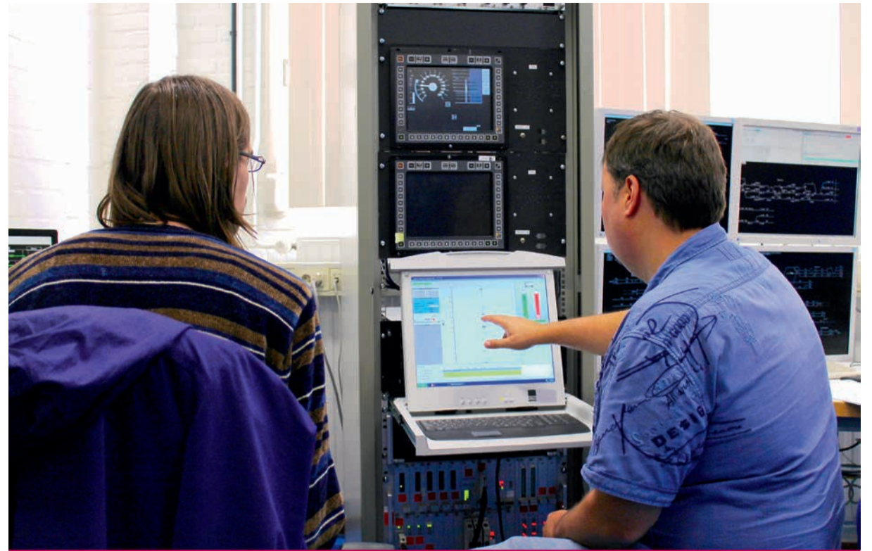
Een kijkje in 'het RIO laboratorium voor ERTMS'
